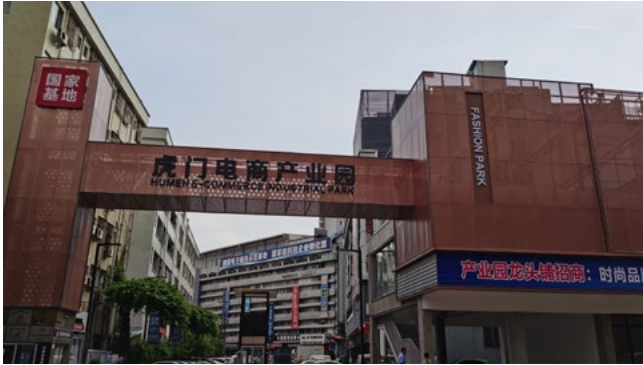
虎门电商产业园
